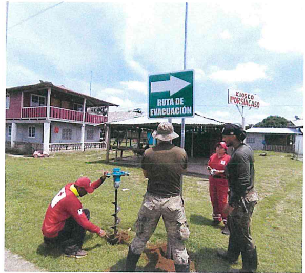
Descripción: Instalación de señalética rutas de evacuación en la comunidad de Canaan MembrillDarien
